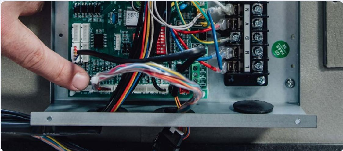
1. Öffnen Sie den Anschlusskasten an dem Umluftkühler und ziehen Sie das Verbindungskabel von X-DIS1 ab.
